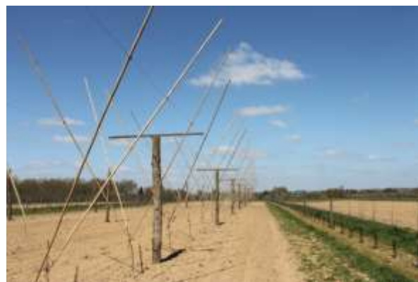
Photo 11 : structure de palissage destinée à la conduite en drilling
